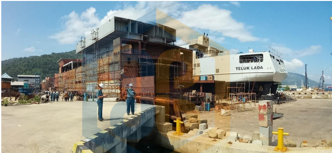
Gamabr 1.2. KRI dalam proses pembangunan di galangan kapal.
