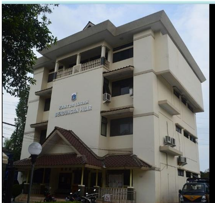
Gambar 4.2 Tampak Depan Kantor
