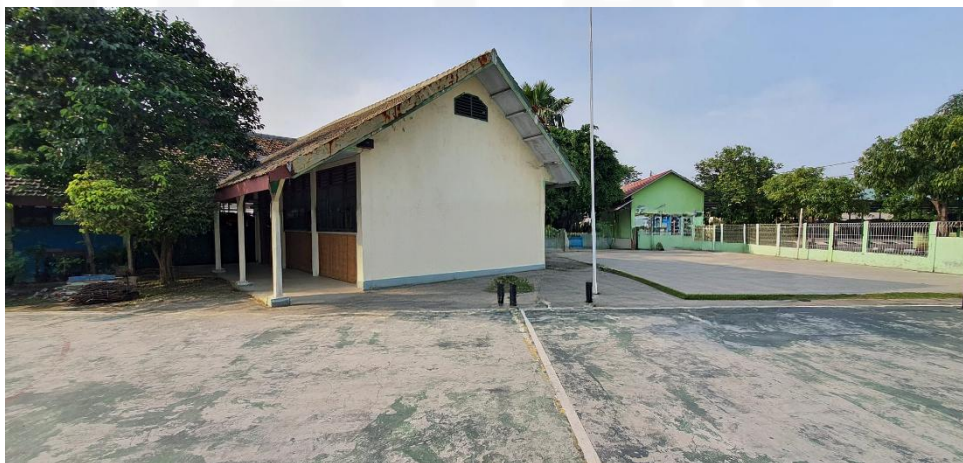
Gambar 1. 1 Tampak Gedung dari samping
