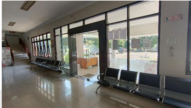
Foto 4.2 Ruang tunggu pelayanan tidak ada pendingin udara
