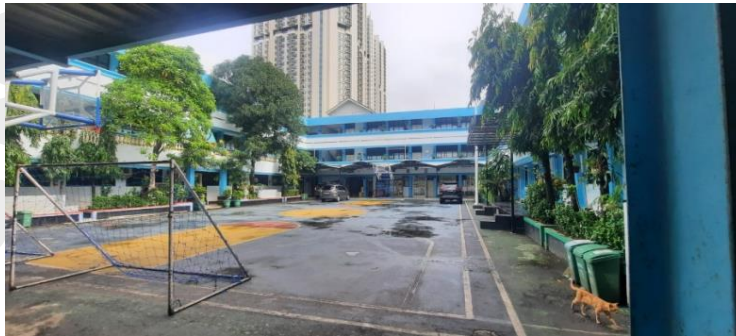
Gambar 4.1 Keadaan Bangunan SMAN 264 Jakarta Sumber: Peneliti
